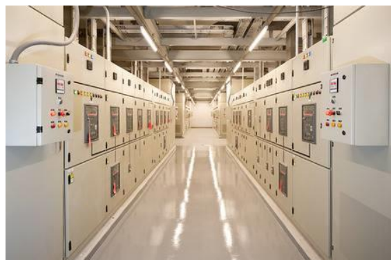
Fig. 5. Centro de control de motores
