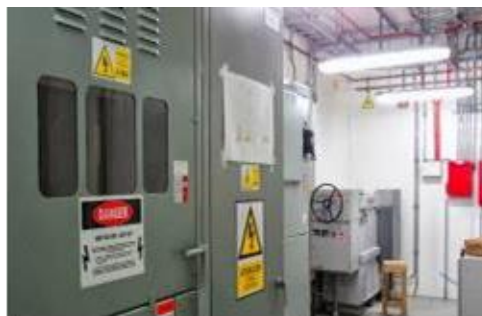
Sala Eléctrica - Interior
