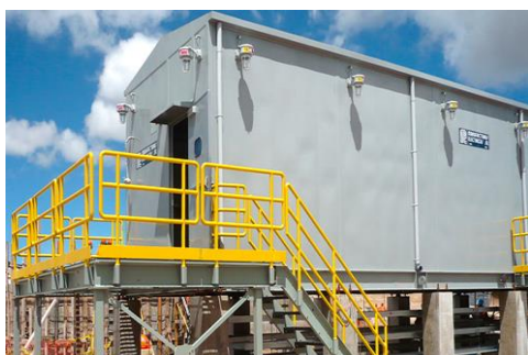
Sala Eléctrica – Exterior
