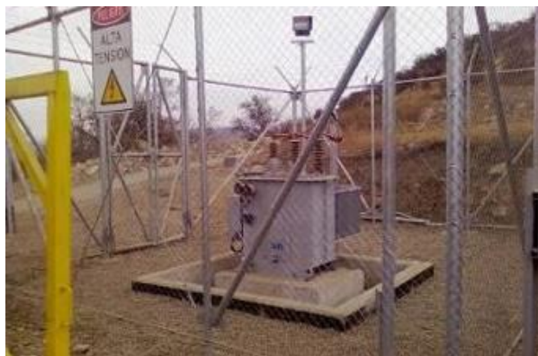
Subestación Eléctrica (SS.EE.)
