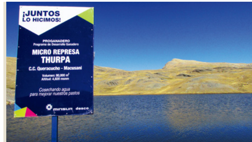
EN EL TECHO DEL ALTIPLANO: Emblemática represa "Thurpa" construida en la comunidad campesina de Queracucho, Macusani, Carabaya para almacenar 80,000 metros cúbicos de aguas de lluvia en pro del riego forrajero.
